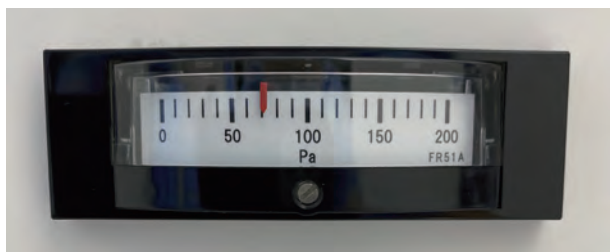
図10 既滅菌エリアの気圧=70Pa
