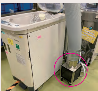
図16 AER(内視鏡洗浄消毒装置)の局所排気設備 高水準消毒薬を使用する部屋には、局所排気装置の設置が推奨されています。
