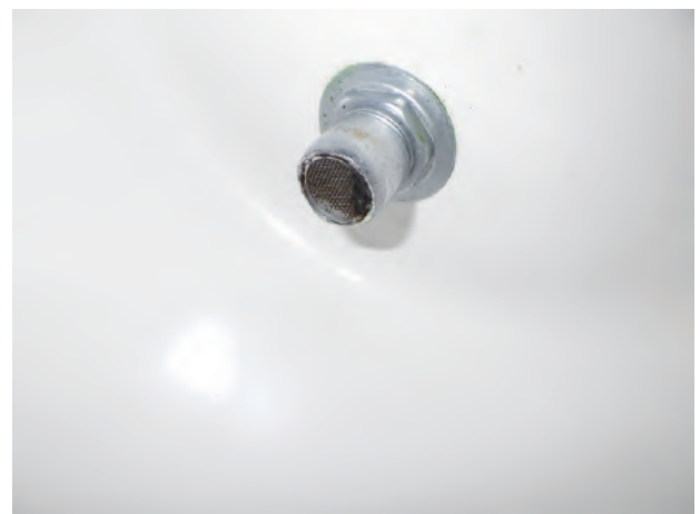
図1 目に見える汚れが付着している自動水栓の蛇口 覗き込まないと汚れが見つからないこともあり、 注意が必要である
