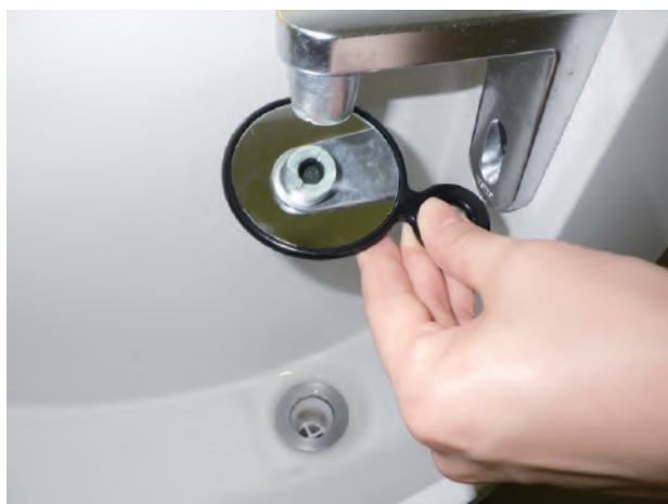
図2 蛇口の確認方法 筆者の施設では、直接視認しにくい蛇口についてはミラーを使用して確認を行っている
