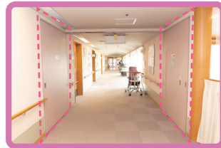
▲ クラスター発生時は 防火扉を閉めてエリア分け
