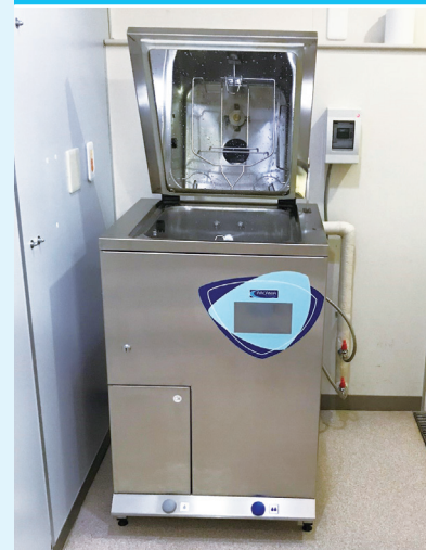
身障者用トイレを撤去し、 ベッドパンウォッシャーを設置
