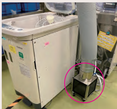
図16 AER(内視鏡洗浄消毒装置)の局所排気設備 高水準消毒薬を使用する部屋には、局所排気装置の設置が推奨されています。
